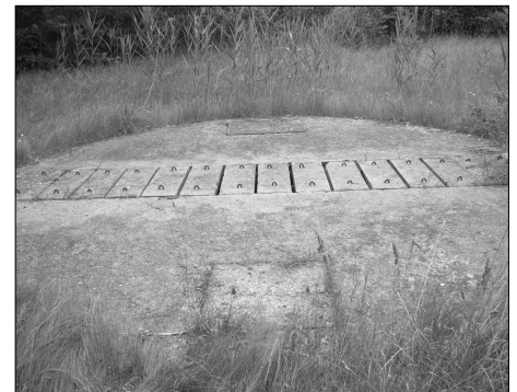
Az aknafedő betonlapok felnyithatók, gyermekekre balesetveszélyt jelentenek.
